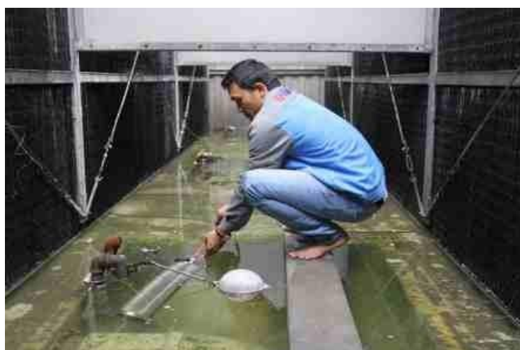
Đặt collector trong tháp giải nhiệt
